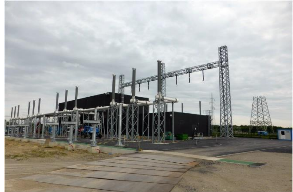
Poste aérosouterrain
